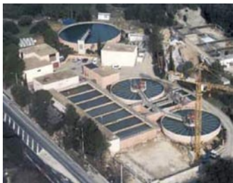
Arago, station de clarification (traitement de l'eau potable). Cliché : Montpellier Agglomération.
