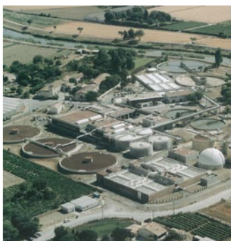
Maera, station d'épuration des eaux usées. Cliché : Montpellier Agglomération.
