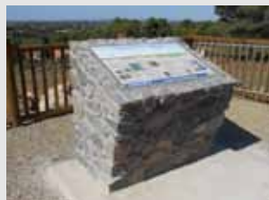
Terrassements et garde-corps réalisés par la commune à Portiragnes.
