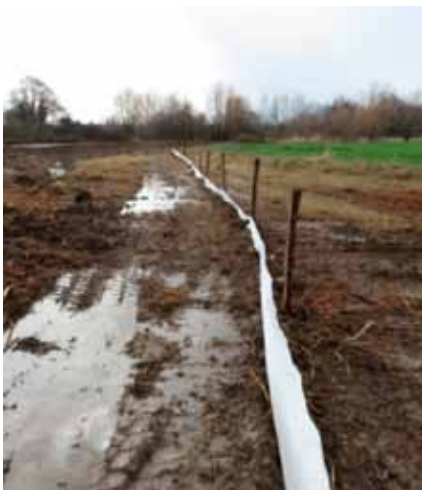
Dispositif sécurisation des amphibiens
